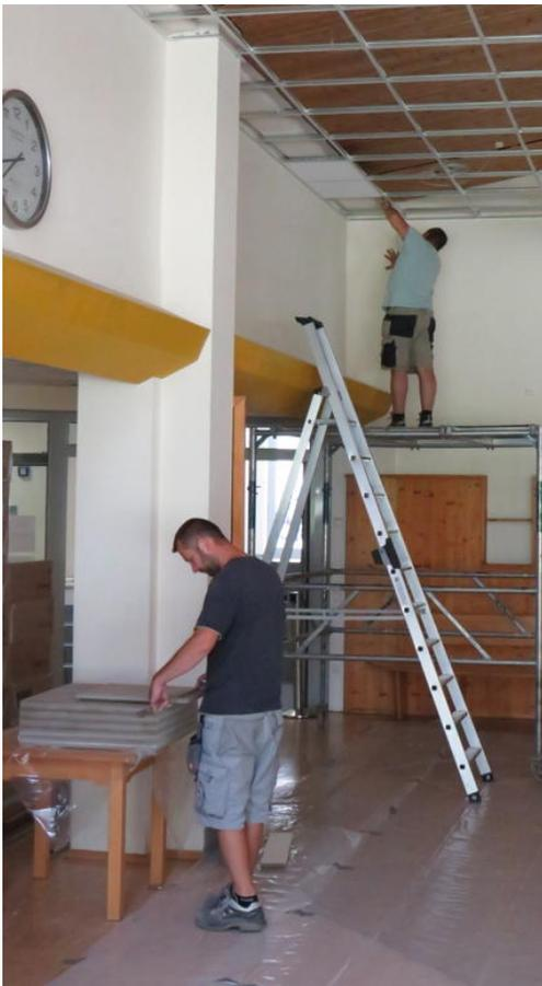
Aus diesem Grunde hat sich der Landkreis dazu durchgerungen, schallschluckende Elemente an der Decke anbringen zulassen. Nicht ganz unkompliziert, musste doch zunächst die Belichtungseinrichtung abmontiert werden, und dann erst konnte man die Unterkonstruktion einziehen. Hoffen wir, dass die Segel ihre Funktion erfüllen.
