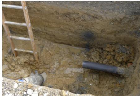
Mit einem Druck von 8bar schoss das Wasser nun durch die Erdschichten an die Oberfläche. Um den Schaden zu reparieren, musste uns die Stadt buchstäblich den
